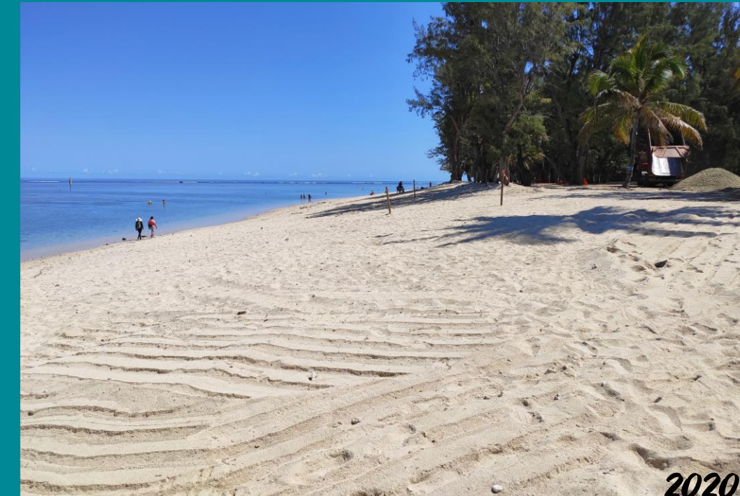
Reprofilage doux avec 2 500 m 3 de sable
