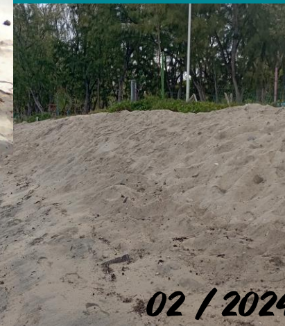
Ré-ensablement avec 1 500 m 3 de sable Sable provenant du Port de Saint-Gilles et de la Plage des Brisants
