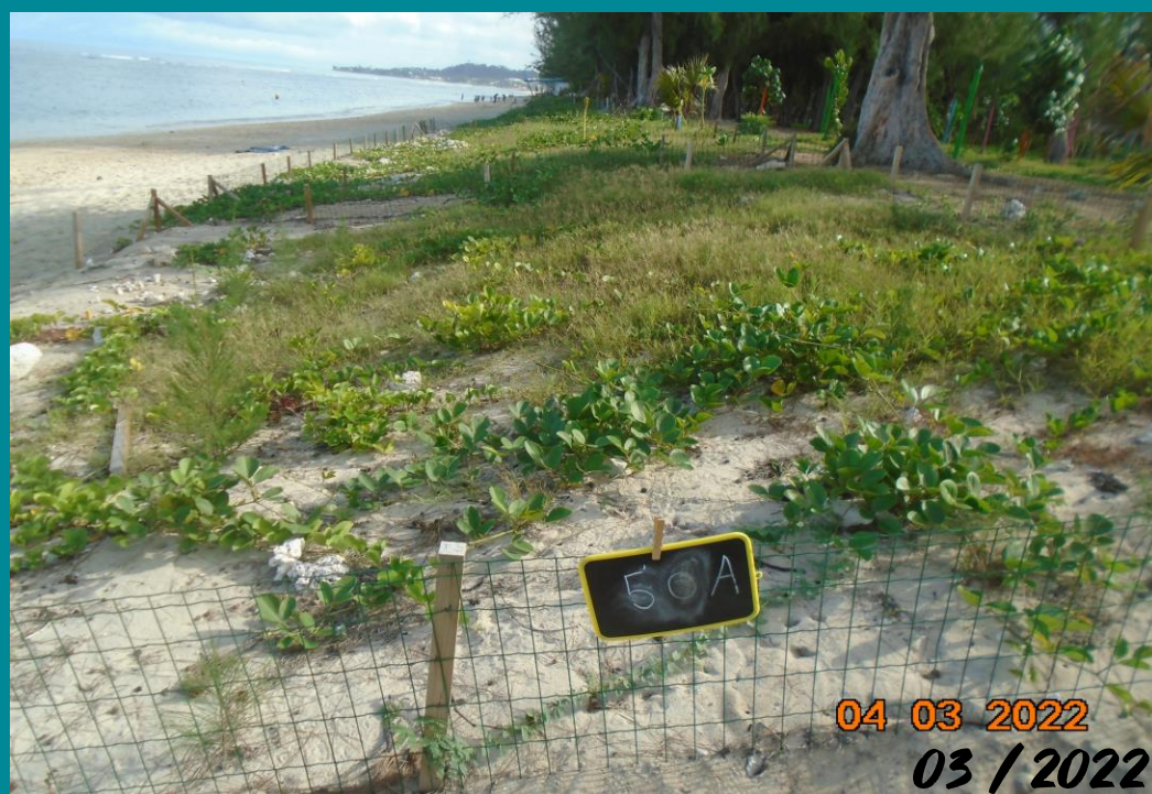
État des plantations des casiers
